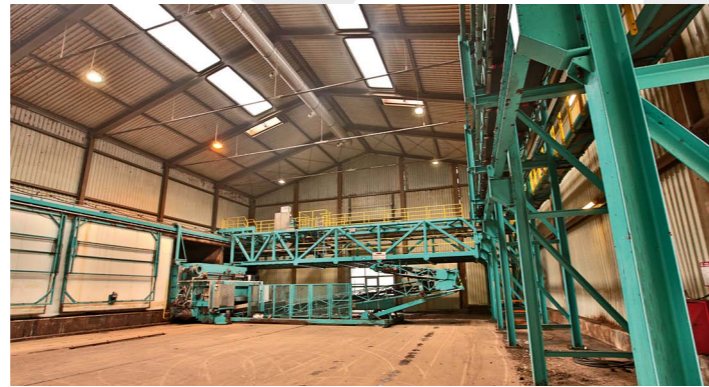
Eintrag in den Rottetunnel
